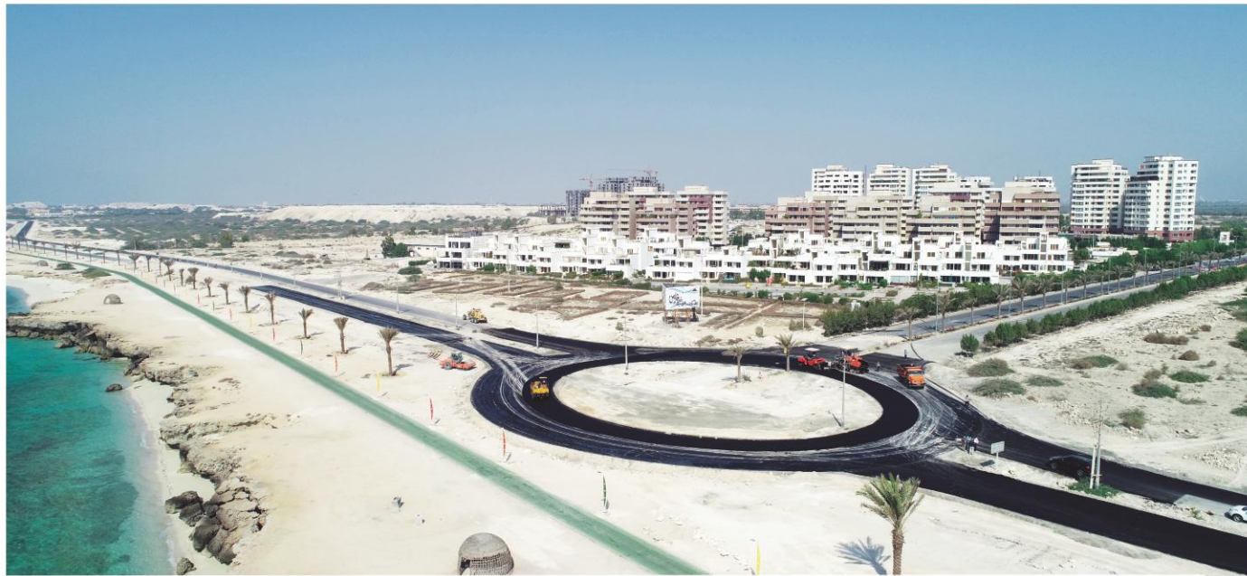
عملیات اجرایی زیرسازی و آسفالت، لکه گیری آسفالت و ترمیم نوارهای حفاری و درزگیری معابر و اجرای لایه حفاظتی (میکروسرفیسینگ) سطح جزیره کیش کارفرما: شرکت عمران آب و خدمات منطقه آزاد کیش محل پروژه: هرمزگان
