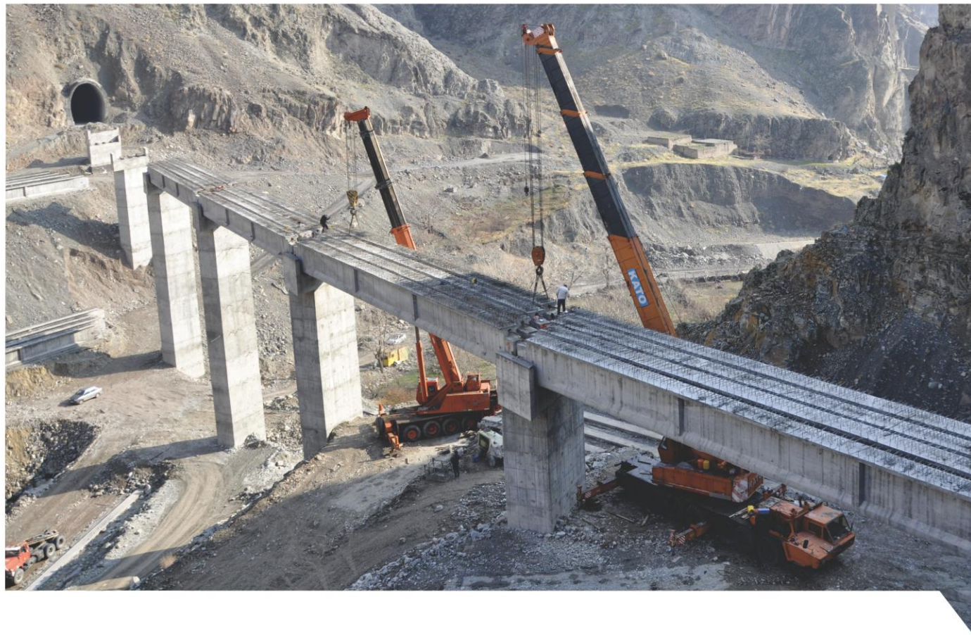
پروژه عملیات زیرسازی قطعه ۲/ج راه آهن میانه - اردبیل
