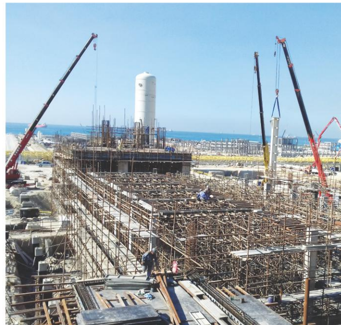
عملیات اجرای سیویل صنعتی، ساختمان و خطوط لوله زیرزمینی پروژه واحد هوا (ASU) محل پروژه: بوشهر کارفرما: شرکت پتروشیمی بوشهر
