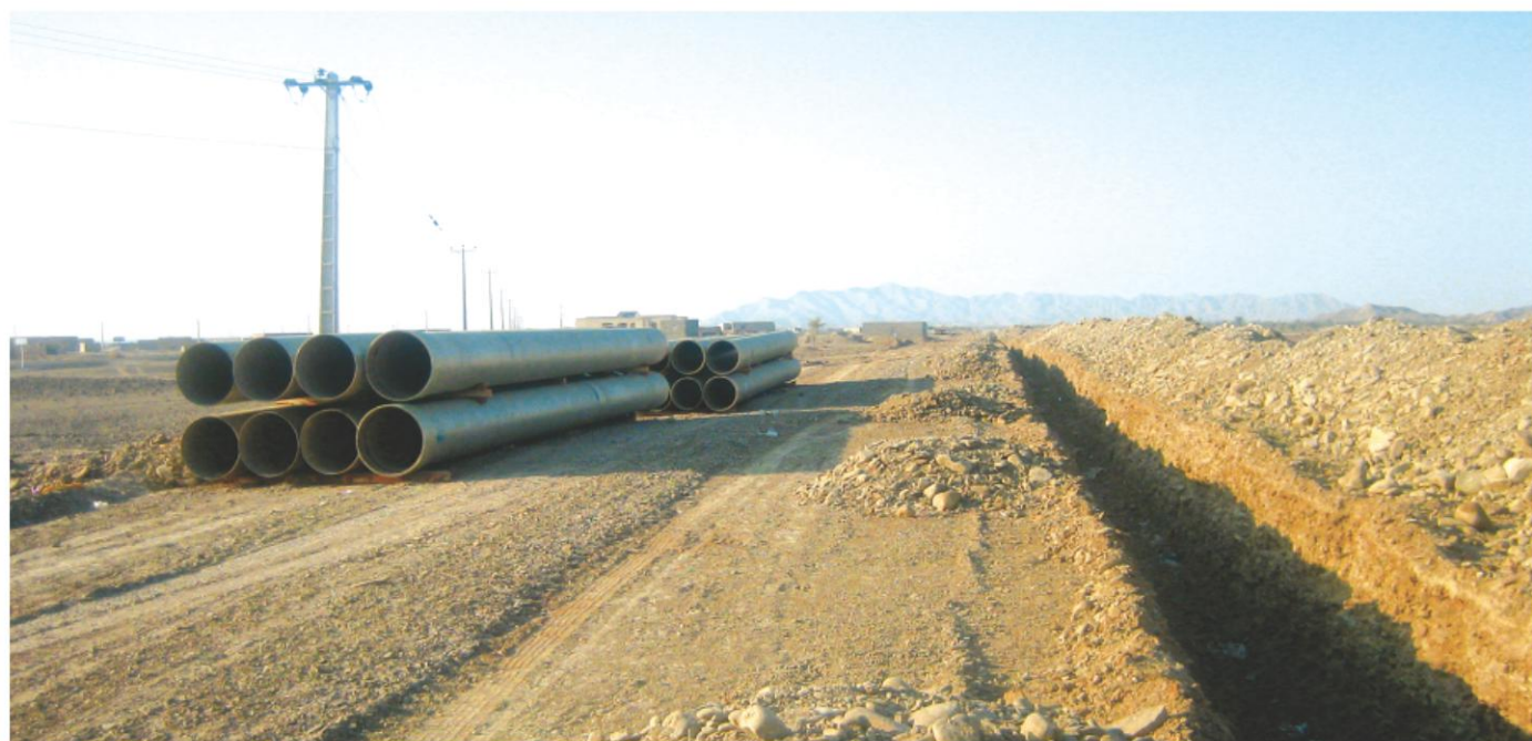
عملیات خرید تجهیزات و اجرای خط انتقال آب به شبکه آبیاری و زهکشی پایین دست سد مخزنی شی کلک محل پروژه: سیستان و بلوچستان کارفرما: شرکت آب منطقه ای سیستان و بلوچستان
