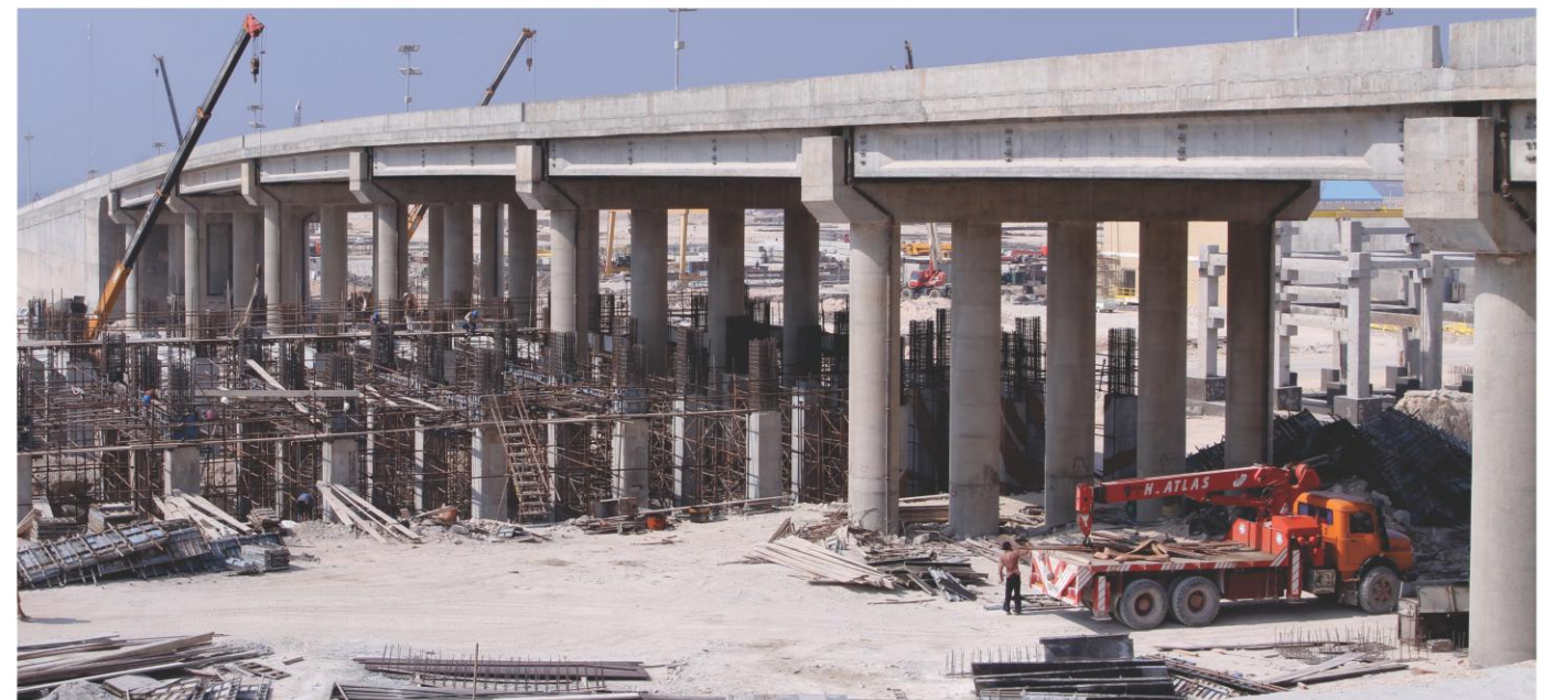
محل پروژه: بوشهر
