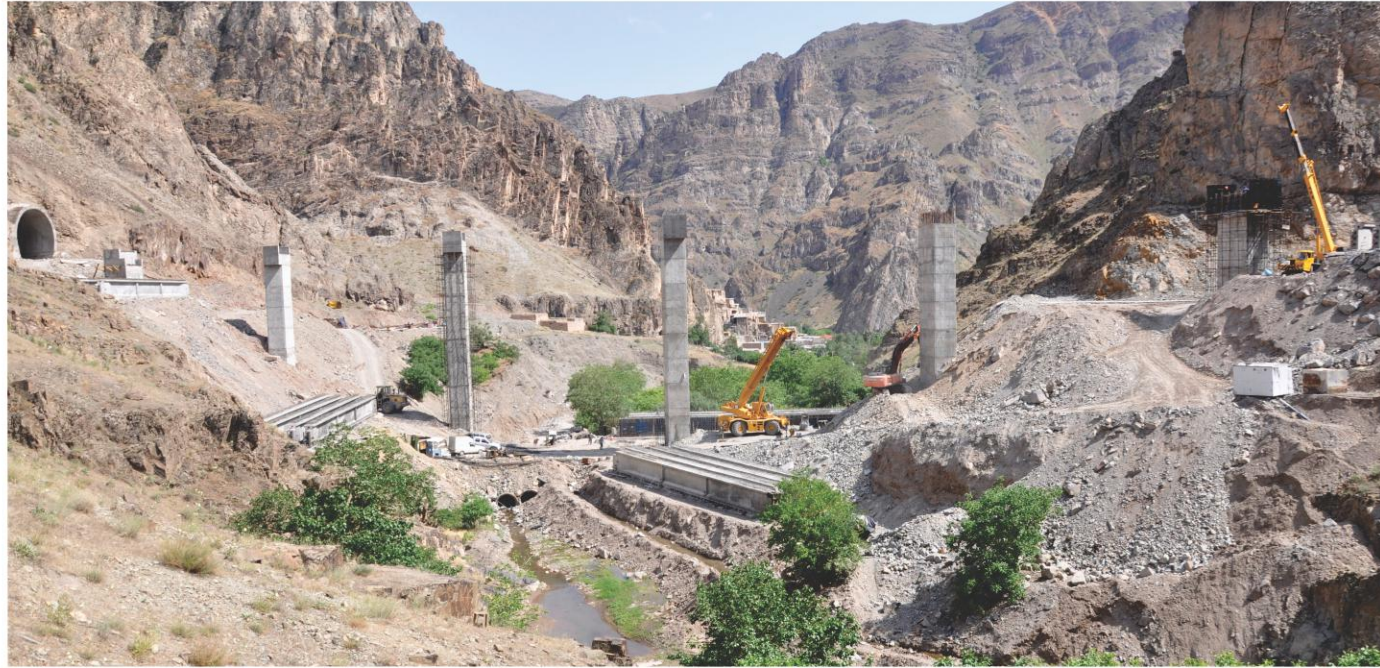
پروژه راه آهن میانه - اردبیل (زیر سازی راه)
