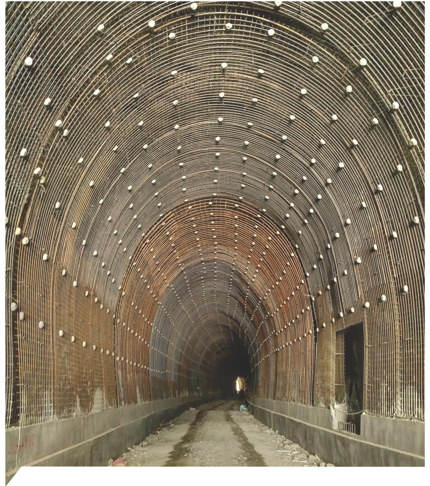
پروژه عملیات زیرسازی قطعه ۲/ج راه آهن میانه - اردبیل
