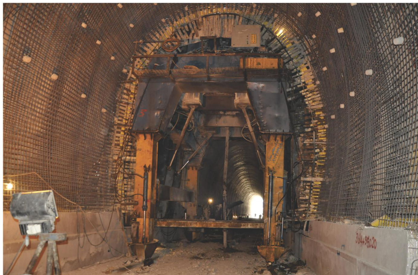
پروژه عملیات زیرسازی قطعه ۲/ج راه آهن میانه - اردبیل
