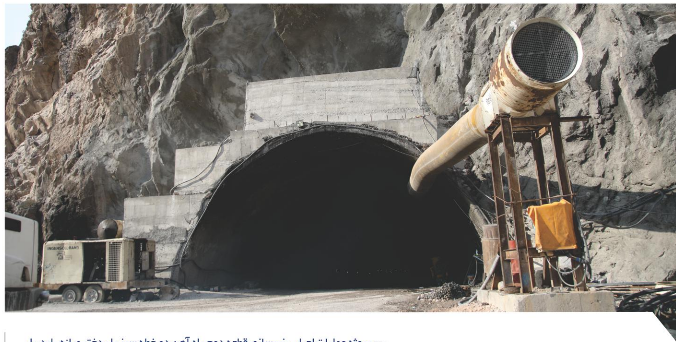
پروژه عملیات اجرایی زیرسازی قطعه دوم راه آهن دو خطه سبز پل دختر میانه - اردبیل
