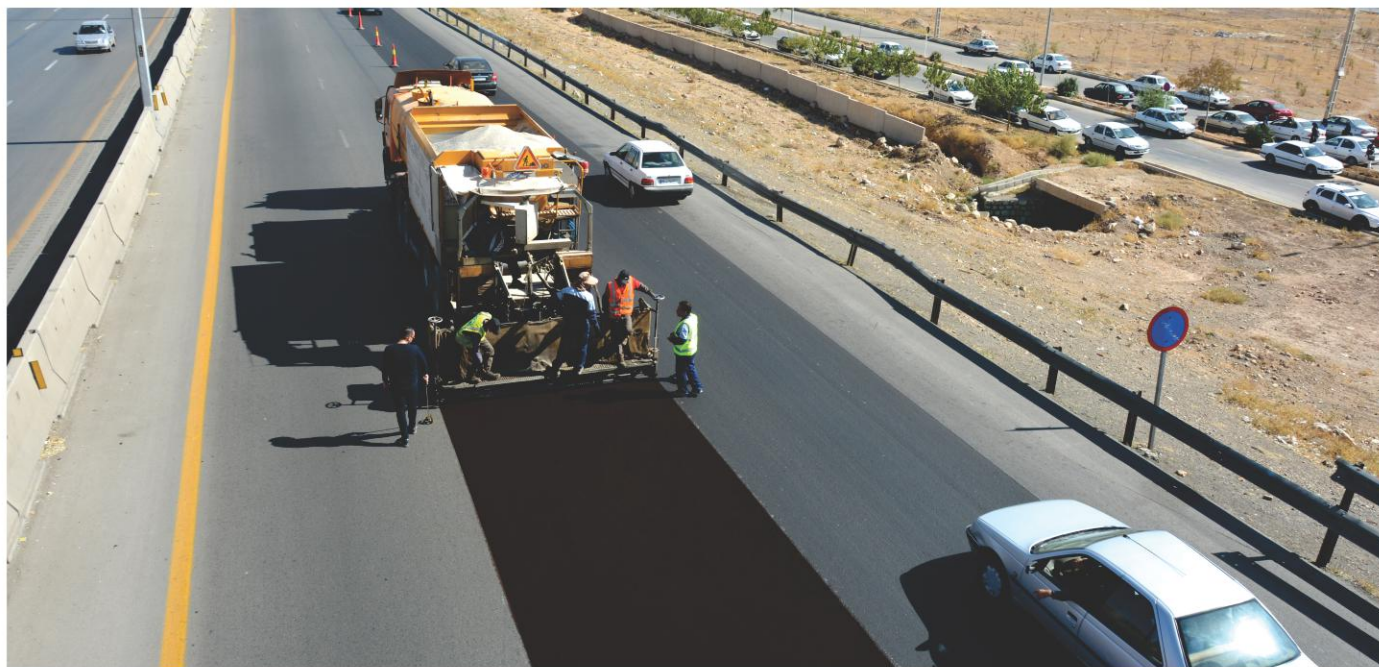
عملیات اجرای روکش حفاظتی میکروسرفیسینگ و اسلاری سیل در راههای حوزه استحفاظی کارفرما: اداره کل راهداری و حمل و نقل جاده ای استان قزوین محل پروژه: قزوین
