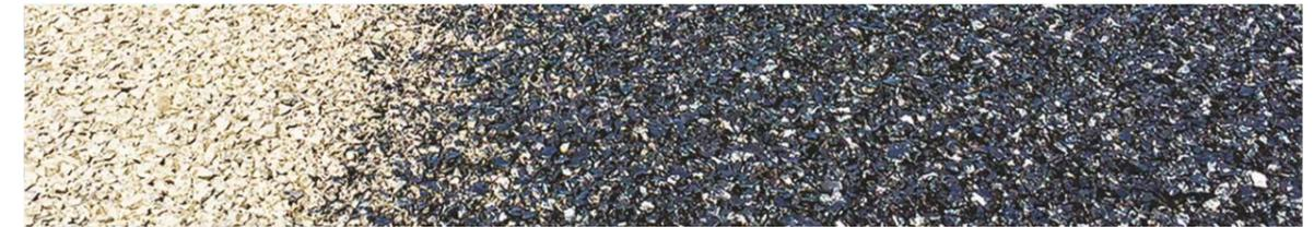
امولسیون های کاتیونی و آنیونی کندشکن معمولاً پس از رقیق کردن با آب به نسبت یک تا پنج برابر مورد استفاده قرار می گیرند. مقدار پخش فاگ سیل در محدوده ۰/۴۵ تا ۰/۷ لیتر بر مترمربع برای امولسیون رقیق شده توصیه می شود. بافت سطحی روسازی، زبری و میزان ترک های آن بر میزان مصرف فاگ سیل اثرگذار است. معمولاً از امولسیون CMS-1 رقیق شده برای فاگ سیل استفاده می شود.
