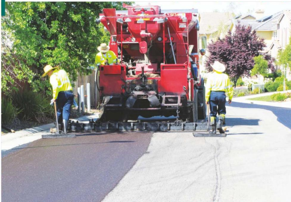
اسلاری سیل با سنگدانه‌های با حداکثر سایز ۳ تا ۱۰ میلی‌متر اجرا می‌شود. امولسیون مصرفی در اسلاری سیل می‌تواند از انواع امولسیون‌های کاتیونی و آنیونی دیرشکن و سریع‌شکن باشد. برای بازگشایی سریع جاده و عبور ترافیک از امولسیون با شکست سریعتر استفاده می‌شود. امولسیون اسلاری سیل می‌تواند دارای لاتکس طبیعی، SBR یا سایر پلیمرها باشد. معمولاً از امولسیون‌های CSS-1 و یا CQS-1h برای اسلاری سیل استفاده می‌گردد.
