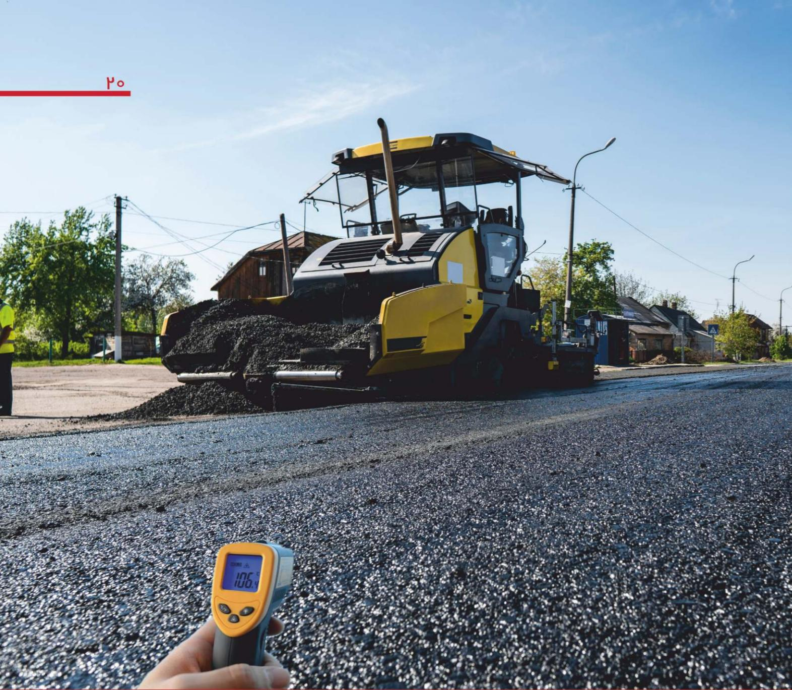
نوع خاصی وکس است که جهت تولید آسفالت نیمه‌گرم WMA، اصلاح خواص قیر و بهبود عملکرد آسفالت مورد استفاده قرار می‌گیرد. با توجه به فرمول منحصر به فرد آن، باعث تسهیل تراکم و کاهش دمای تولید و تراکم آسفالت و همچنین افزایش عمر آسفالت می‌شود. از این افزودنی می‌توان در پروژه‌های با فواید حمل طولانی و شرایط آب و هوای سرد در هنگام اجرا استفاده نمود. میزان مصرف این افزودنی در محدوده‌ای ۱/۵ - ۳ درصد وزنی قیر است.
